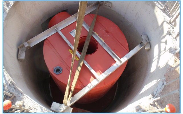
Ensamblado y alineación del Separador Hidrodinámico en el pozo de registro.
