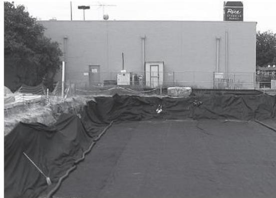
Coloque el geotextil no tejido sobre la base y los taludes de la excavación.
