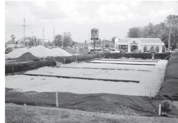
Coloque el árido angular limpio y procedentes de machaqueo en la base de mínimo 230mm. Instale los drenes de fondo si es necesario. Compacte para lograr una superficie plana y lisa.
