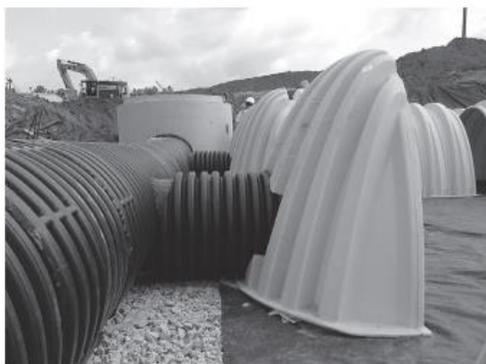
Alinee la primera cámara y la pieza de terminación de cada hilera con las tuberías de entrada. El contratista puede optar por posponer la cubrición con grava en las cámaras de los extremos y dejarlos abiertos para facilitar la inspección de las cámaras durante el proceso de relleno.
