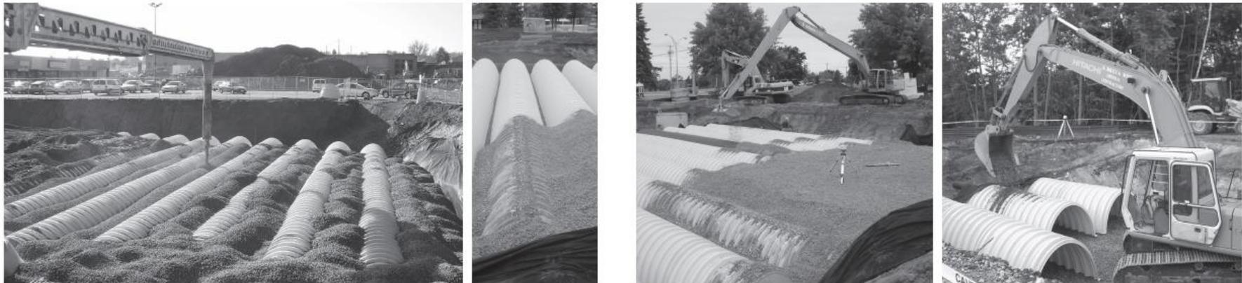
El relleno inicial debe efectuarse a lo largo de la línea central de las cámaras fijando uniformemente la parte inferior de la cámara. Esto se consigue utilizando una banda transportadora o una excavadora que alcance toda la longitud de la hilera.
