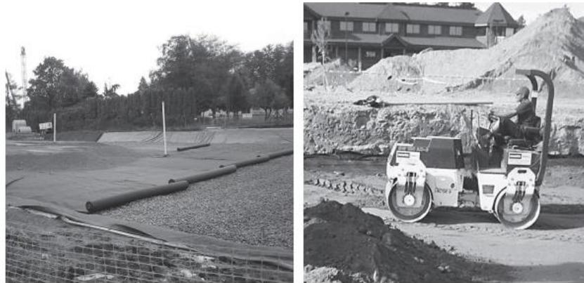
Instale geotextil no tejido sobre la piedra de cubrición. El geotextil debe solaparse 600 mm mín. en sus extremos. Compacte a tras 600 mm de relleno. El recorrido de los rodillos va paralelo a las hileras.
