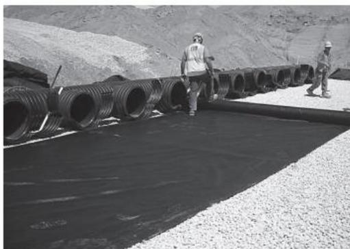
Instale los colectores de entrada y coloque el geotextil tejido en las hileras de entrada [mín. 5,33 m] en cada pieza de terminación de entrada. Coloque una franja continua (sin solapes) a lo largo de toda la longitud de la(s) fila(s) de aislamiento-tratamiento en una doble capa.
