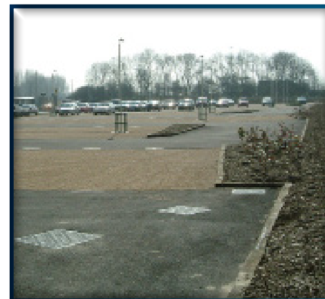
Fig6: Aparcamiento con sistema de drenaje y controlado por un regulador de caudal Drenatura Hydro-Brake®
