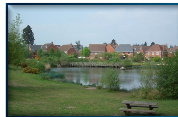
Fig4: El desarrollo urbano Elvetham Heath en Hampshire utilizó 18 válvulas de regulación Drenatura Hydro-Brake® como parte de un sistema de SUDS ejemplar.
