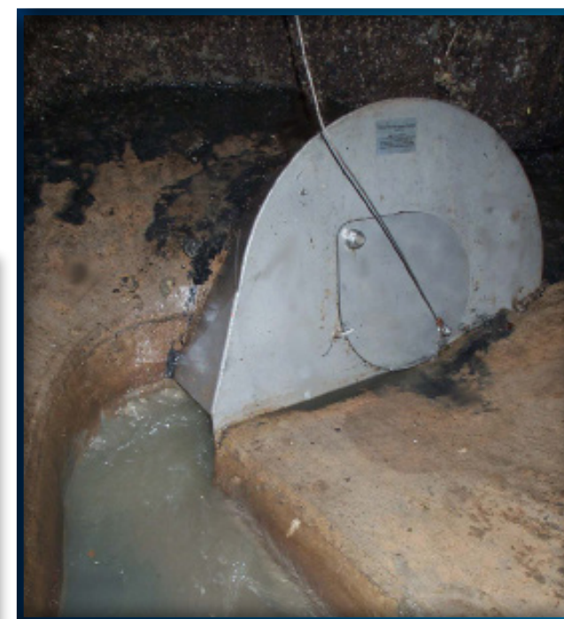
Fig8: Regulador Drenatura Hydro-Brake® en cámara húmeda con bypass pivotante integrado.
