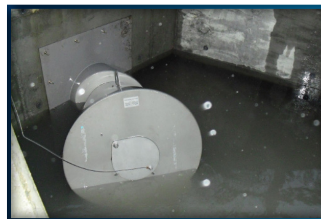
Fig7: Reguladores de caudal Drenatura Hydro-Brake® formando parte de una solución sostenible para un nuevo y prestigioso parque empresarial.
