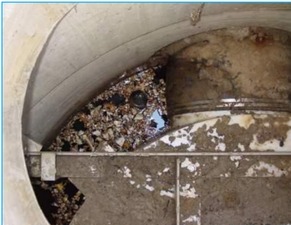
Fig. 8. Residuos sólidos flotantes acumulados junto a la tubería de descarga de la unidad.
