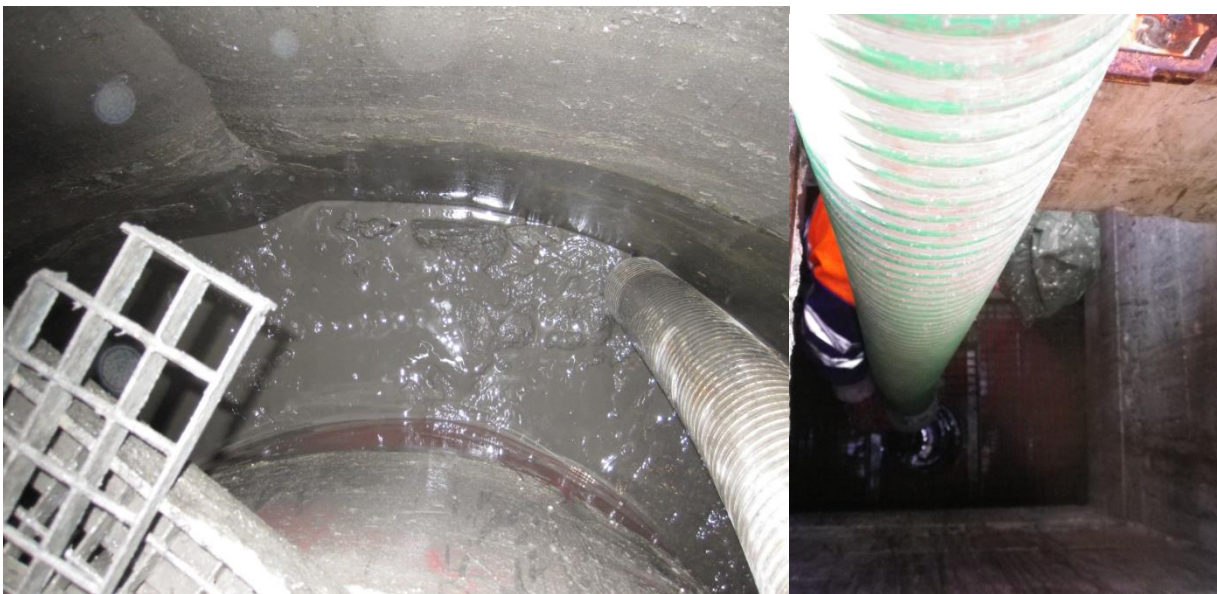
Fig. 6. Trabajos de limpieza mediante camión aspirador en zona de flotantes (izquierda) y en zona de sedimentos (derecha) de Separador Hidrodinámico Downstream-Defender-Drenatura®
