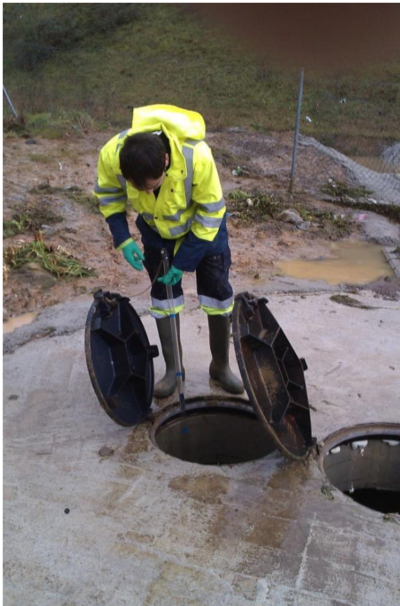
Fig. 3. Apertura de tapas y medición de lodos en inspección del Separador Hidrodinámico Downstream-Defender-Drenatura®
