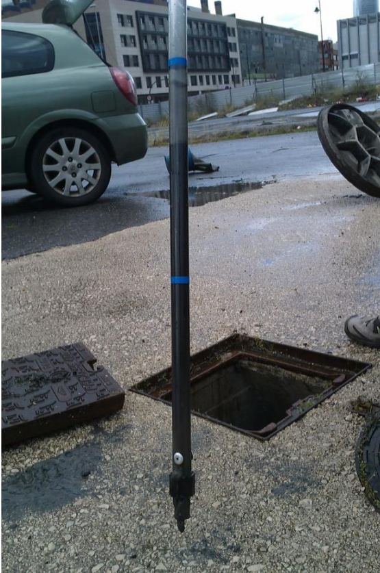
Fig. 5. Medición de cantidad de lodo en el interior del Separador Hidrodinámico Downstream-Defender-Drenatura®
