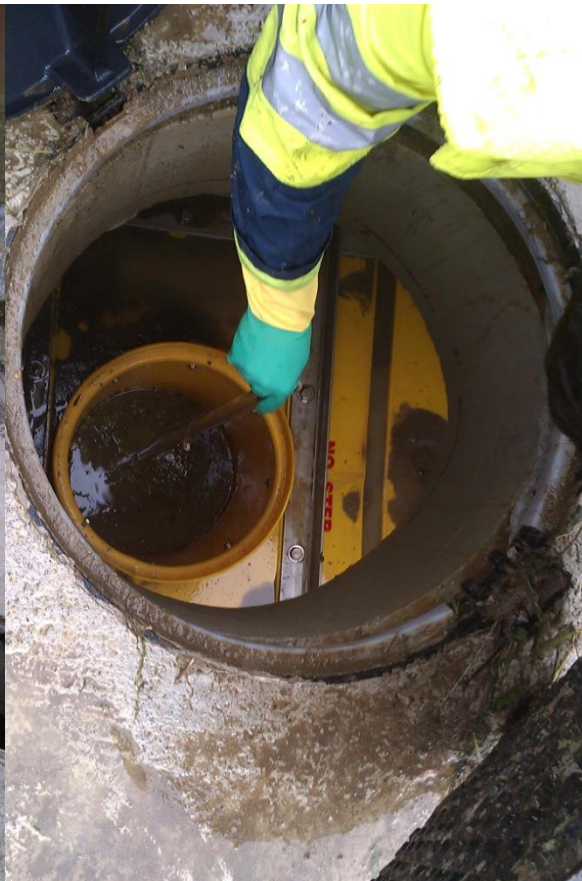
Fig. 4. Introducción de medidor de lodos a través de agujero central del Separador Hidrodinámico Downstream-Defender-Drenatura®
