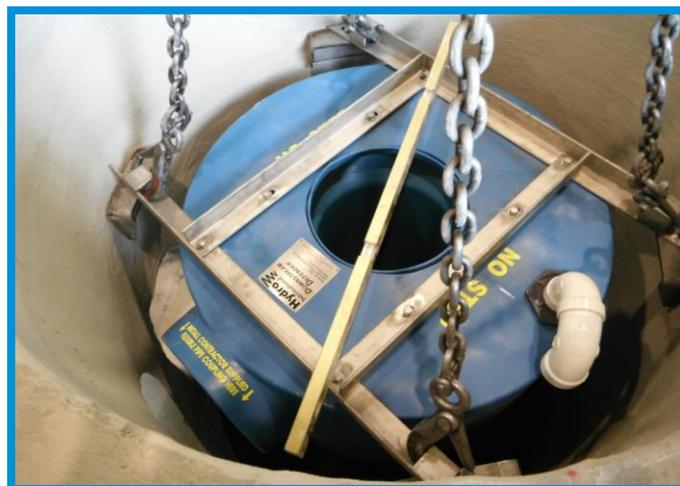
**Fig. 2.** Componentes internos de la unidad ensamblados en el interior de arqueta.
