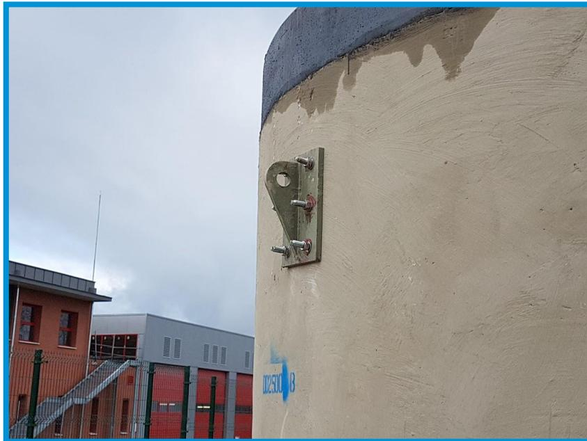
Fig. 4. Rampas de anclaje para manipulación de unidad.
