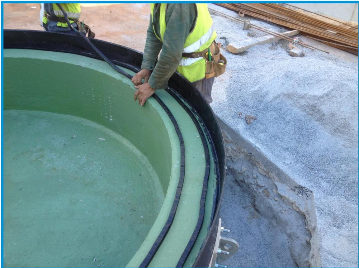
**Fig. 7.** Colocación de junta bentónica entre anillos para estanqueidad, colocar junta en parte central ya que expande unos 2 cm. **IMPORTANTE** – Una vez adherido el pozo superior será difícil rotarlo o moverlo por lo que la colocación de la pieza superior debe guiarse con especial cuidado para dejarla en su posición definitiva.
