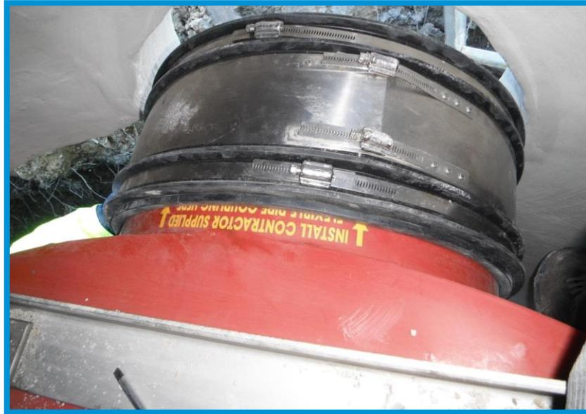
Fig. 3. Acople flexible para conexión entre el equipo y la tubería de salida
