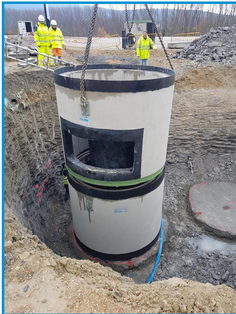
**Fig. 6.** Colocación de base y anillo superior en unidad DD2500 con posición marcada en la losa de apoyo.
