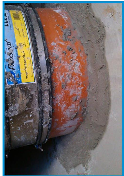
**Fig. 11.** Ventana y taladro recibidos con mortero hidrófugo u hormigón de consistencia seca
