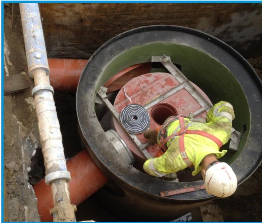
**Fig. 10.** Presentación y corte del tubo tangencial de entrada en la ventana rectangular.
