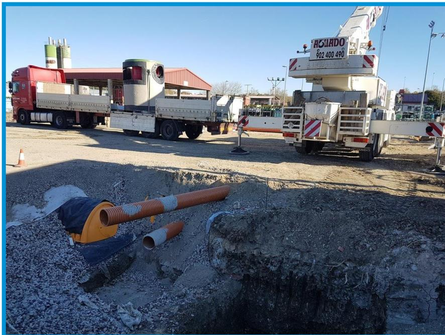
**Fig. 1.** Plataforma y grúa para manipulación de la unidad en explanada adecuada junto a excavación donde se ubicará la unidad.
