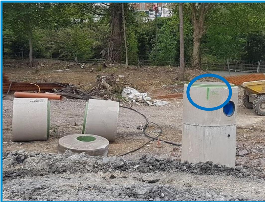
**Fig. 12.** Alinear marcas exteriores de los pozos para correcta orientación de los anillos.
