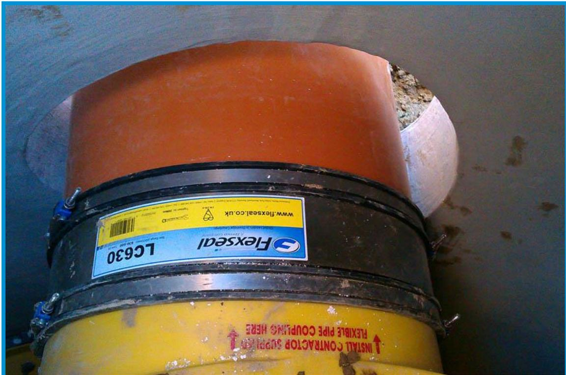
**Fig. 8.** Colocación abrazadera en el tubo de salida, el contratista debe introducir el tubo hasta que haga tope dentro de la misma y apretar ambas abrazaderas con destornillador. En los casos en los que se empleen tubos de distintas dimensiones a los recomendados por Drenatura se requiere usar anillos compensadores para abrazar el tubo de salida y aumentar su diámetro en el punto de apriete de la abrazadera.
