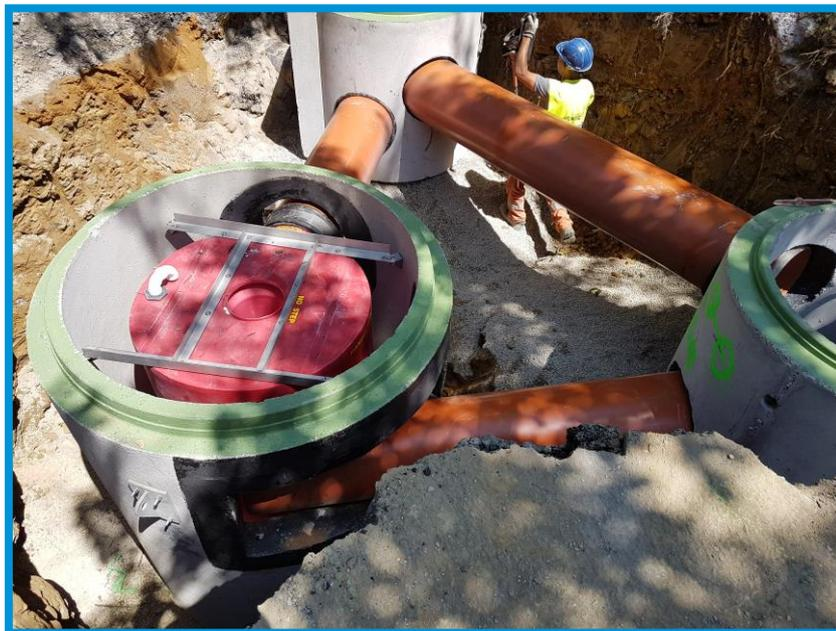
**Fig. 9.** Presentación del tubo tangencial de entrada en la unidad a través de la ventana rectangular.
